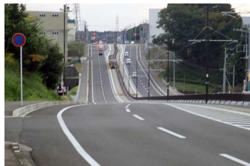
写真8 1000mに対して高低差62mの急勾配でも支障なく運行OK
